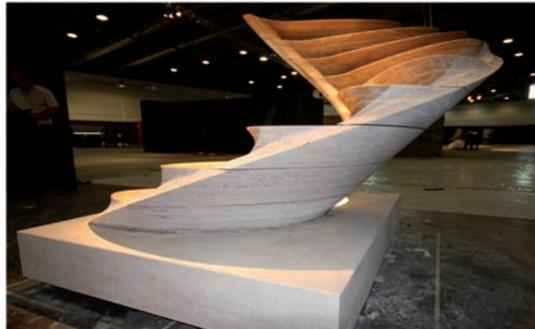
fonction de la géométrie en hélice. Chaque marche sera soutenue par deux des trois barres et la troisième sert à ancrer de manière réciproque et progressive. Chaque barre filetée est composée de trois éléments, jointée par des connexions, de manière à
