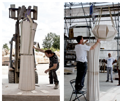
Les stagiaires au travail sur le montage de l'arbre, avec une ossature qui relie les voussoirs formant les branches et le tronc. L'ensemble réalisé en Roche de Valange, mesure 3,20 m de haut pour un diamètre de 4,30 m. Il a également été chargé pour en éprouver la stabilité.
