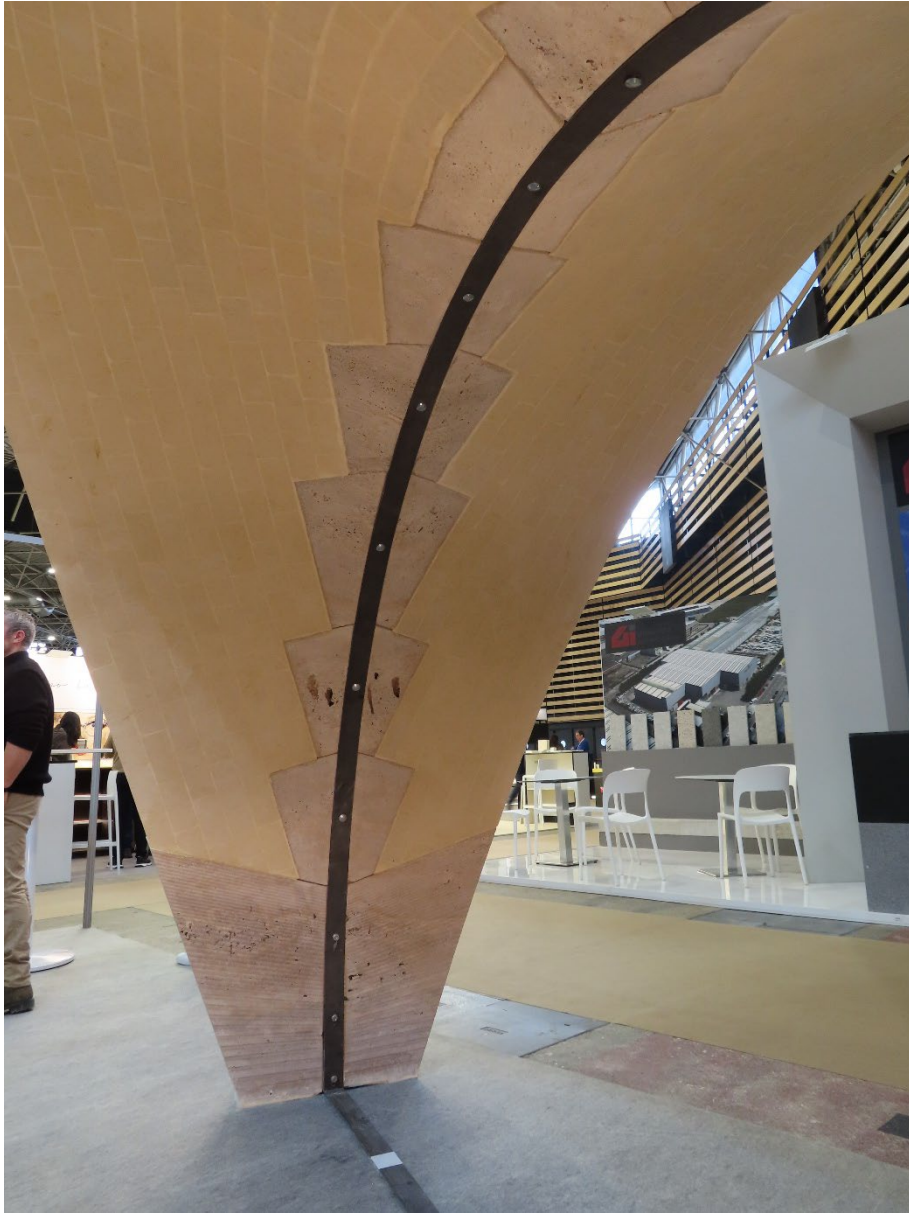
Vue en détail de l'intérieur de la voûte maçonnée (1 ère couche)
