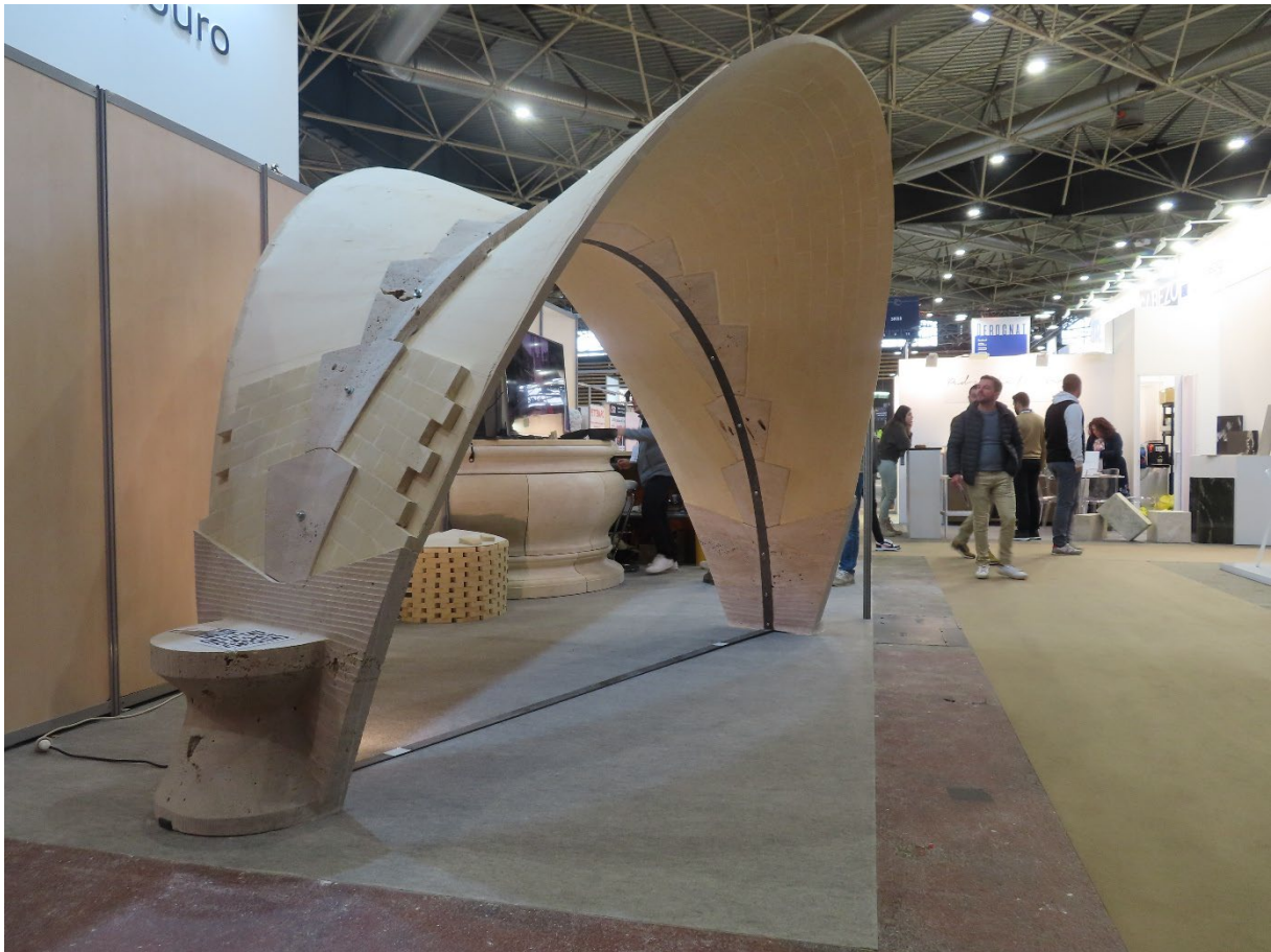
Vue générale de la voute maçonnée
