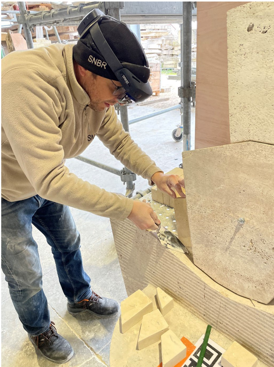
Vue des essais de maçonnerie via réalité mixte / HoloLens 2 (Microsoft)
